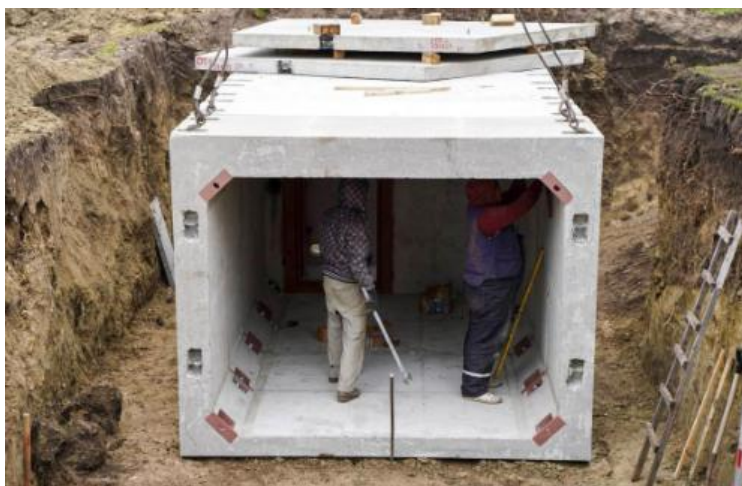
Attēls. Dzelzsbetona bloku konstrukcijas 4
